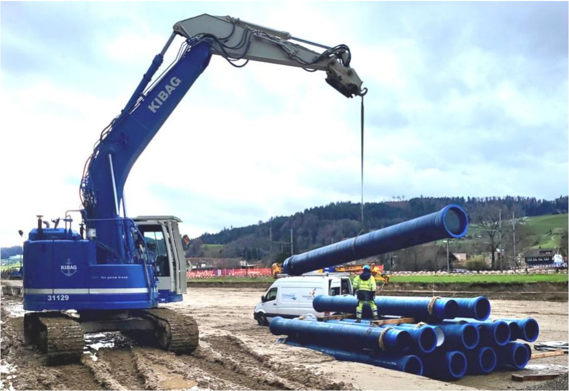
Oben: Umlegung DN 500 Quellzubringerleitung II Hasle
