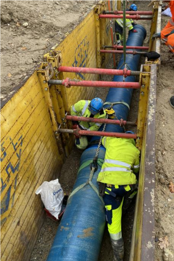
Links: Einbau DN 500, Quellzubringerleitung II Hasle
