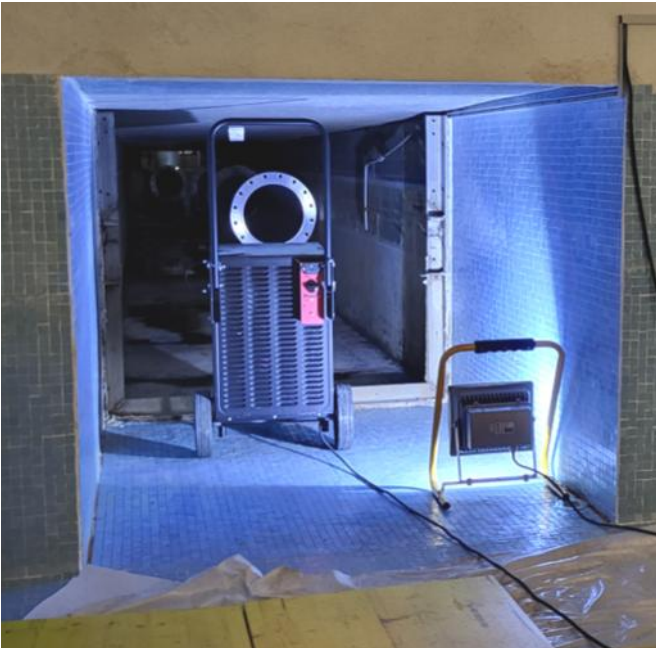
Unten: Sanierung Zulaufkanal Reservoir Rohrmoos
